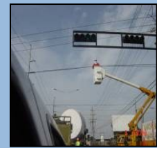
Figura 8: Personal de Corpoelec que levante el cableado.
